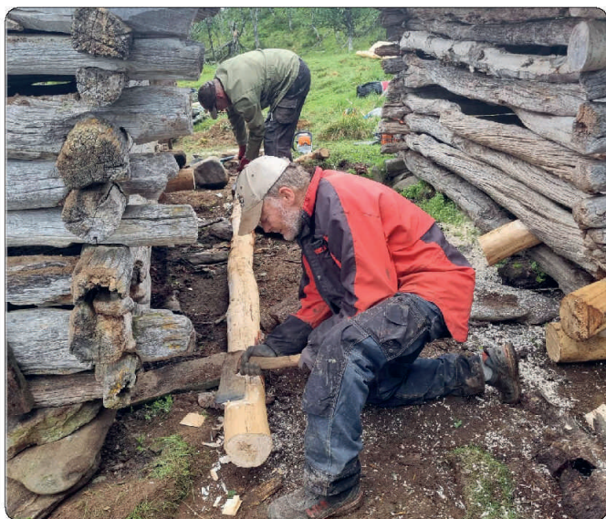
Thor Arne Rosten og Tormod Haugen økse kjinner på en ny botnstokk i bjørk. Det er viktig å både bruke samme type materiale og så langt det er mulig de samme redskapene som da løene ble satt opp første gangen.
