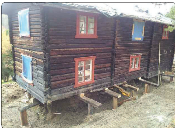
Huset ble jekket opp og det ble lagt nytt gulv og nye sylstokker.
