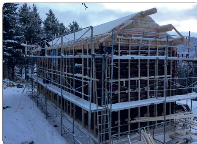
Gulv og tak på plass!
