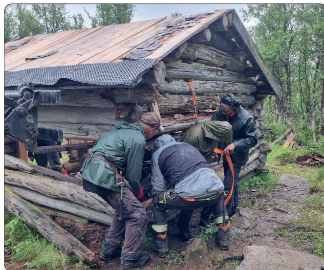
Det måtte jeggas og løftes, lirkes og lures, og løa var på tur til å bekke flere ganger. Tormod Haugen, Arnstein Enget, Arne Olav Persvingelen og Arve Trøan.
