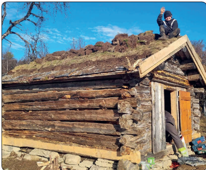
Restaurering. Utbedringer av taket pågår, og en ny stokk har kommet på plass nederst på løa. Mats hilser til fotografen. T.h.: Gutta krutt i aksjon når gulvet skal rives. Aksel, Torjus, Henrik, Erik, Ingvar Lars Lauritz og Domantas.
