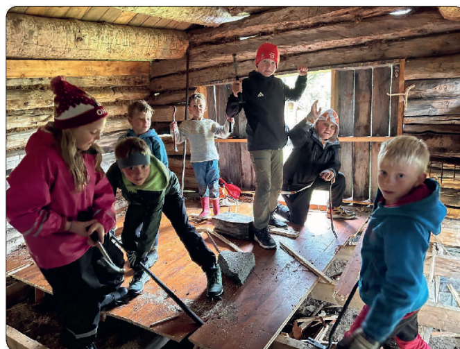
Hele gjengen i aksjon med å rive gulv
